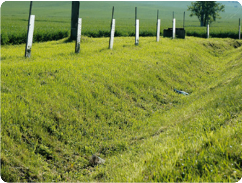
图2：捷克共和国内草坡铺设的截留沟（Dzurakova et al. · 2017）
