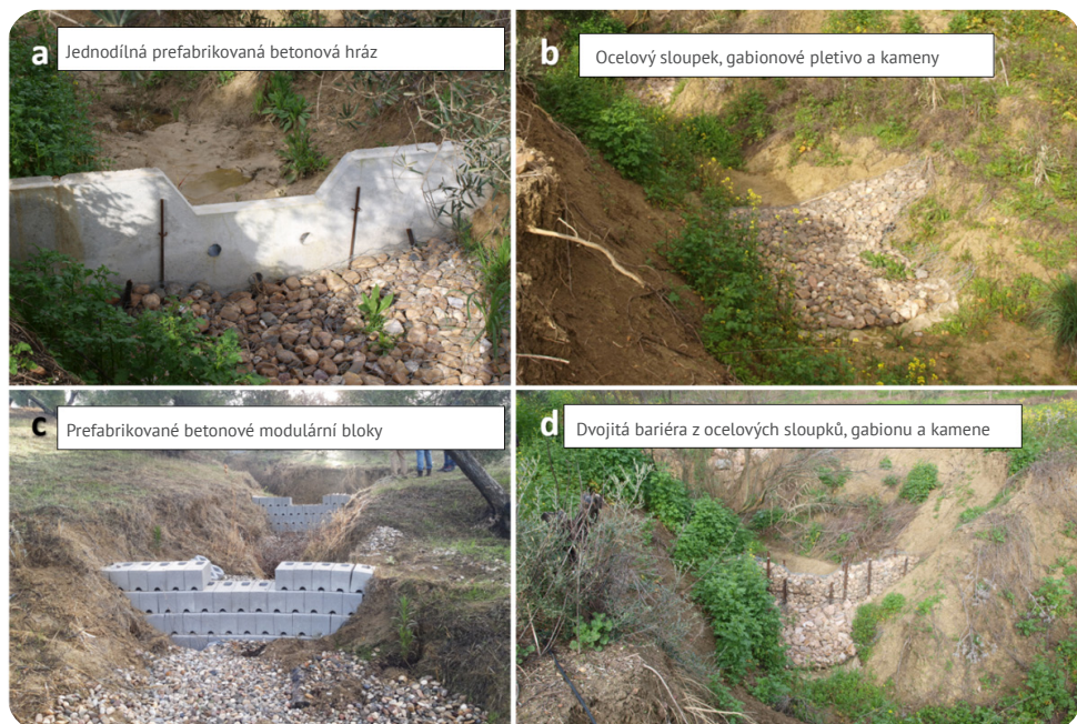
Obrázek 1: Hráže strží s různými konstrukčními technikami.
