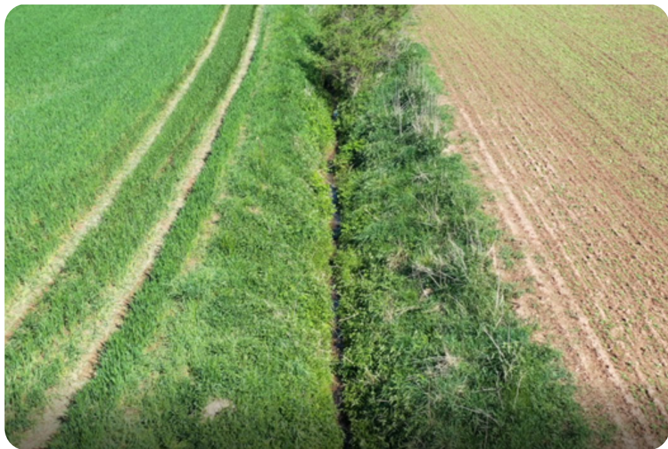
Obr. 3: Malý odvodňovací příkop jako součást systému odvodnění (Česká republika).
