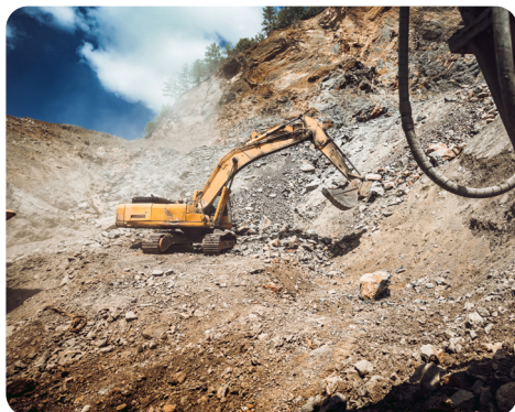
Erosione del suolo.
